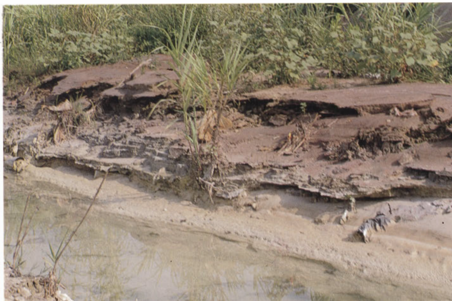
Foto 35: il Canale di Montignoso in condizioni di magra nel tratto compreso tra le stazioni 3 e 4. Si notino, immediatamente a contatto con l'acqua, i depositi di polvere di marmo, bianchi e molli. Più in alto sono evidenti depositi cementati color rosso di fanghi di lavorazione del granito, sedimentatisi in condizioni di maggior portata.
