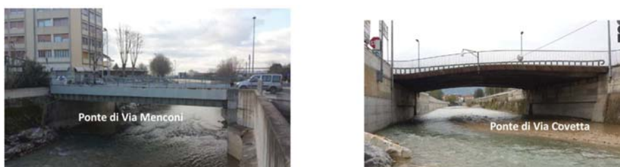
Figura 1.14: Il Ponte di Via Covetta ed il Ponte di Via Menconi
