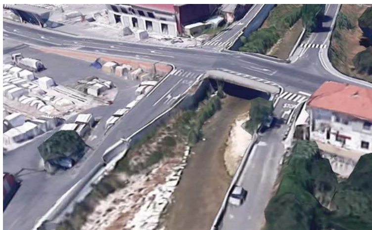
Figura 1.17: Immagine satellitare del tratto di corso d'acqua in cui insiste il Ponte di via Covetta, in cui si nota il restringimento di sezione da esso indotto (immagine Google Earth).
