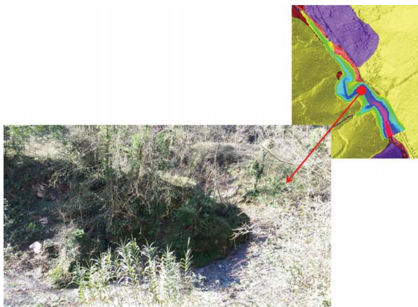
Figura A.5: Ansa del Gragnana in corrispondenza dello sbarramento Sorgnano 2
