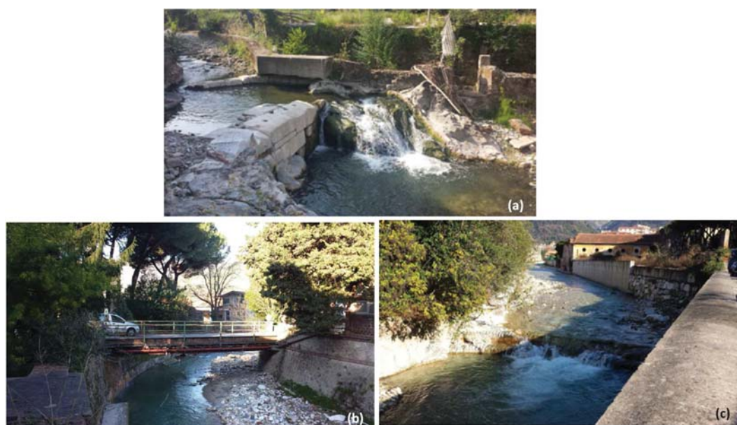
Figura 1.37: Soglia localizzata alla sezione 82 (a), passerella per accesso privato localizzata alla sezione 85, vista da valle (b) e soglia localizzata alla sezione 87.1, vista da valle (c)
