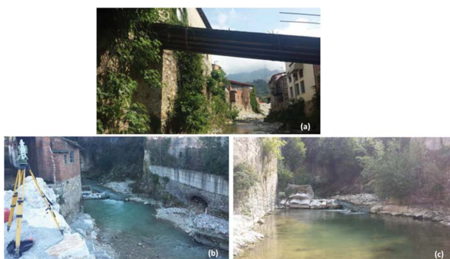
Figura 1.40: (a) Passerella localizzata alla sezione 91.3 (vista da valle); Soglia localizzata alla sezione 93.1, vista da monte (b) e vista da valle (c)
