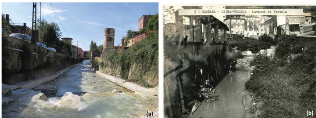
Figura 2.14: (a) Soglia localizzata in s124.1 vista da monte. (b) Configurazione di questo tratto del Carrione negli anni '60. In sponda destra erano localizzati i lavatoi di Vezzala. Si noti la presenza di vegetazione in alveo, accompagnata da forti depositi
