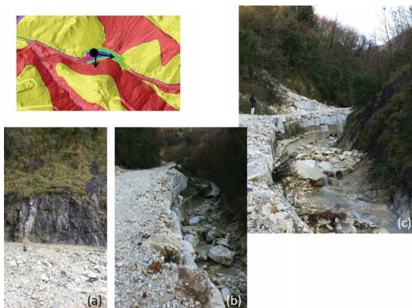
Figura A.42: Alcune immagini in corrispondenza dell'invaso Colonnata 1 (loc. Mortarola)
