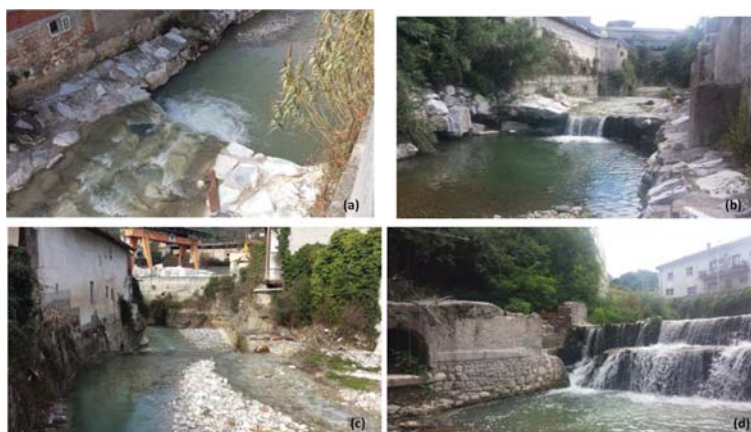
Figura 1.34: Soglie localizzate alla sezione 74.1 (vista da monte (a) e da valle (b)) e alla sezione 76.1 (vista da monte (c) e da valle (d))
