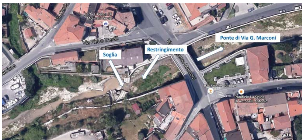
Figura 1.29: L'alveo subisce un innaturale forte restringimento in prossimità della soglia a valle del ponte di via Marconi.
