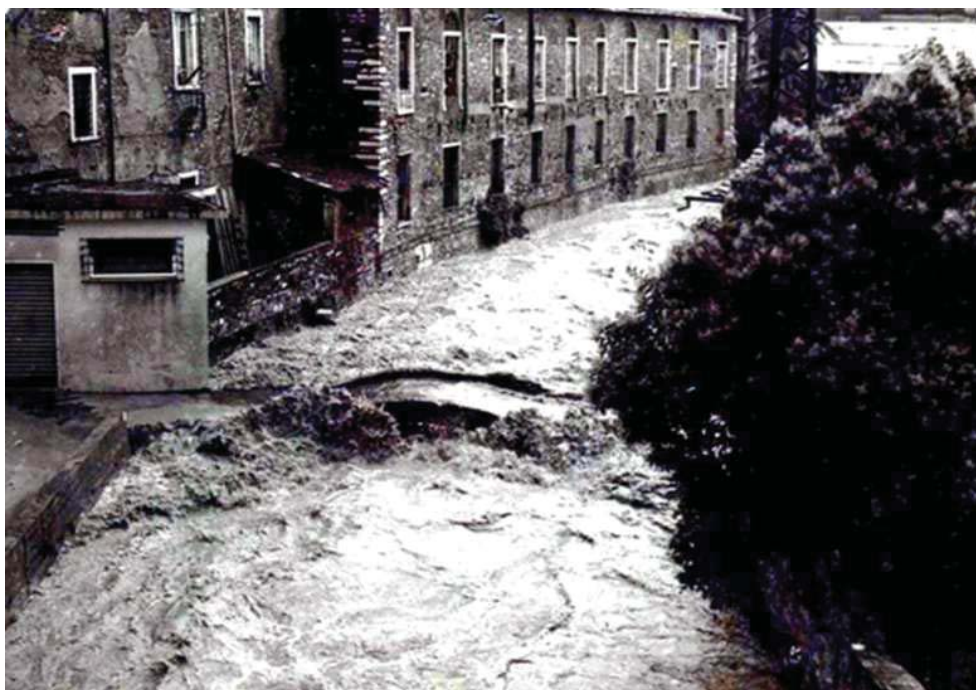
Figura 1.12: Immagine del Ponte Groppoli nel corso dell'esondazione del 24 Luglio 1968
