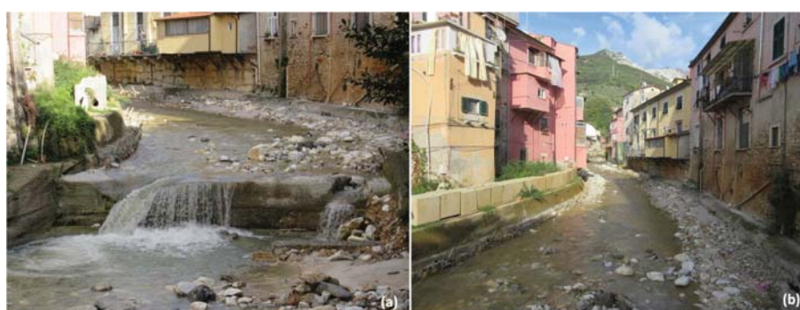
Figura 2.12: Soglia a monte del fabbricato Forti (a) e tratto del corso d'acqua a monte della soglia: sullo sfondo si intravede il ponte della Bugia (b).
