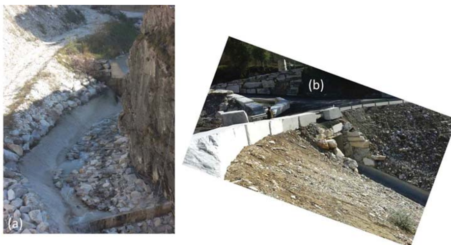
Figura 3.21: Interventi di regimazione delle acque a monte del Ponte di Sponda (a) e in ravaneto sul fianco sinistro del bacino del Gragnana (b).
