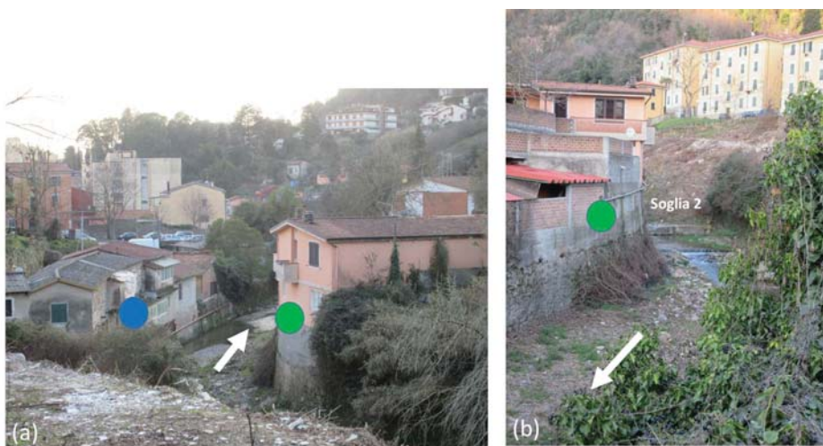
Figura 3.16: Il tratto del Gragnana compreso fra i ponti indicati come ponte 2 e ponte 1 in Figura 3.13.
