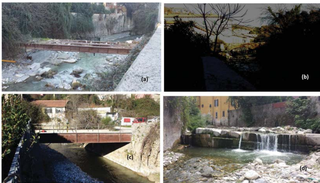
Figura 1.42: Passerella localizzata nella sezione 93.4 (a); Ponte di S. Martino localizzato nella sezione 96 (b); passerella privata localizzata alla sezione 98A (c); soglia localizzata alla sezione 99.1 (d)
