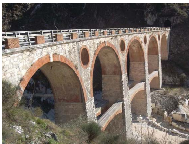
Figura 3.9: Vista di uno dei tre ponti di Vara e dell'imbocco della galleria che porta alla Stazione di Tarnone
