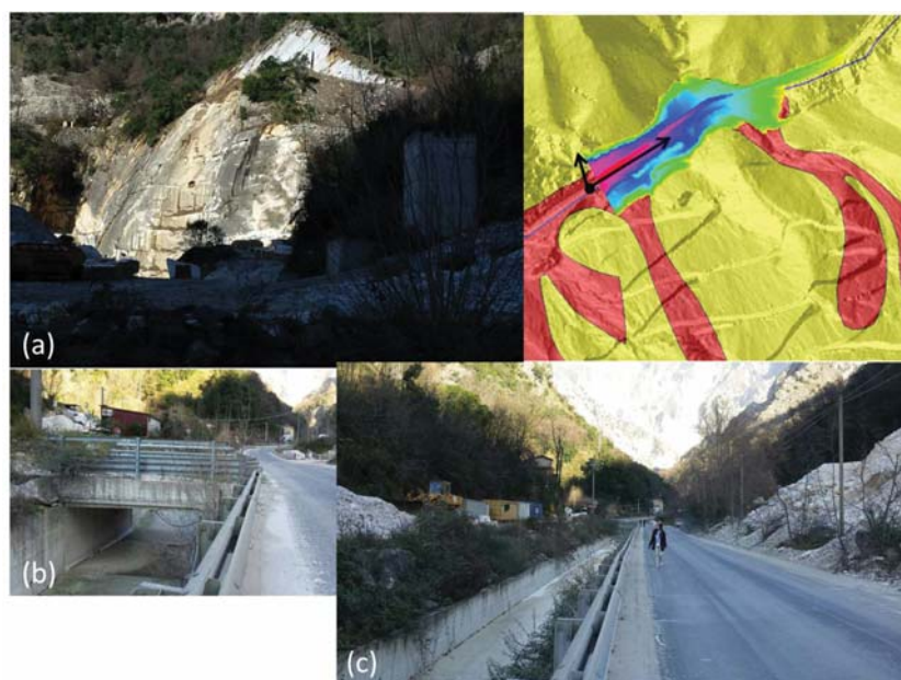
Figura A.18: Fronte di cava aperto (a) e strada al servizio delle cave (b, c) presenti in corrispondenza dello sbarramento Torano 4
