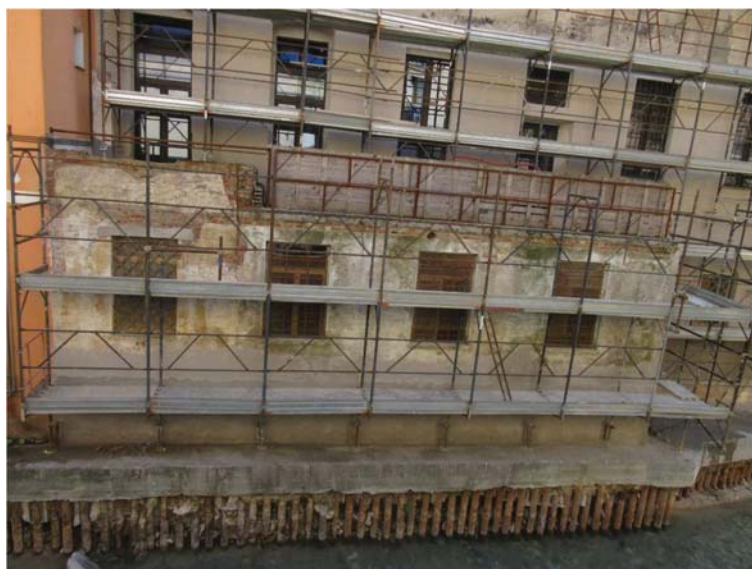
Figura 2.2: Processo di abbassamento del fondo a monte di Via Apuana, evidenziato dall'emergere della parte più alta della palificazione recentemente realizzata
