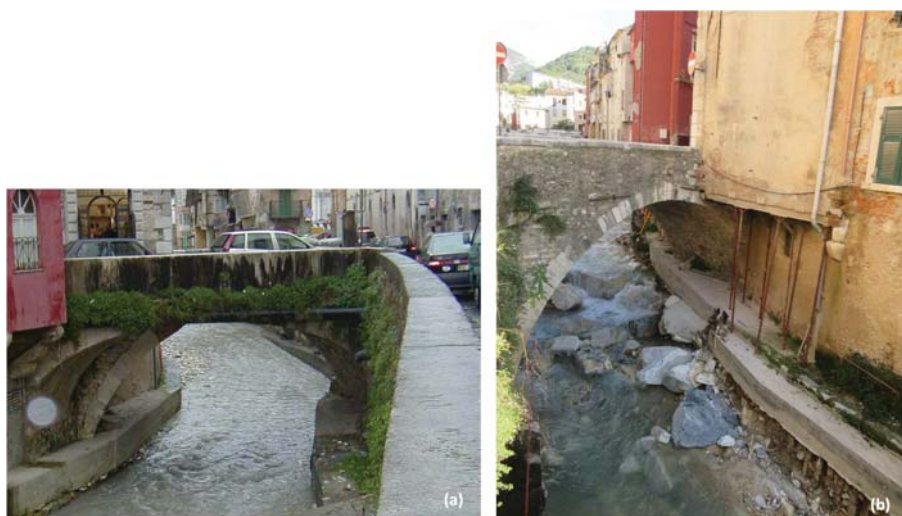
Figura 2.6: Ponte del Baroncino (sezione 110) visto da monte (a) e da valle (b).
