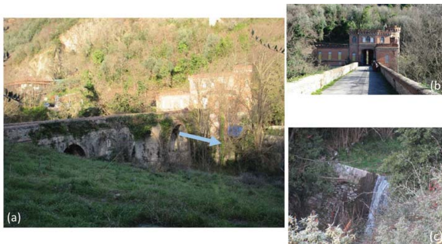
Figura 3.14: (a) Il ponte a tre arcate di Villa Fabbricotti sul Gragnana; (b) l'accesso alla villa attraverso il Ponte; (c) la soglia molto alta subito a valle del ponte
