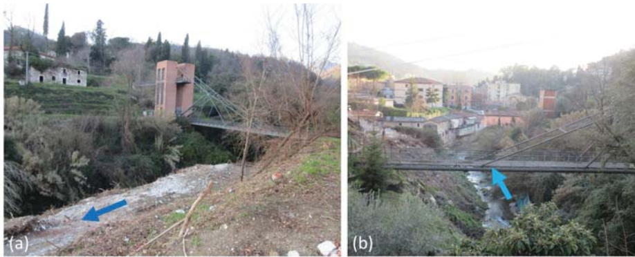
Figura 3.15: Il ponte sospeso sul Gragnana (ponte 2 in Figura 3.13)
