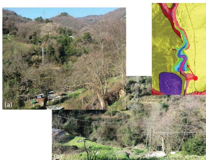
Figura A.3: Vista della valle (a) e dell'alveo incassato del Gragnana (b) in corrispondenza dello sbarramento Gragnana 2
