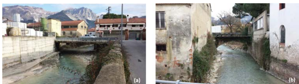
Figura 1.35: Il ponte di via Stabbio alla sezione 79 visto da valle (a) ed il ponte carrabile privato Peghini, sezione 81 visto da valle (b)
