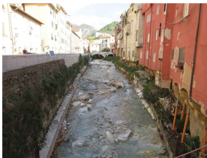
Figura 2.7: Il tratto del Carrione compreso fra Ponte del Baroncino (sezione 110) e ponte delle Lacrime che si intravede sullo sfondo.
