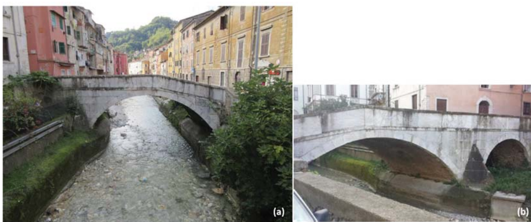
Figura 2.8: Il Ponte delle Lacrime nella configurazione attuale, visto da monte (a) e da valle (b)
