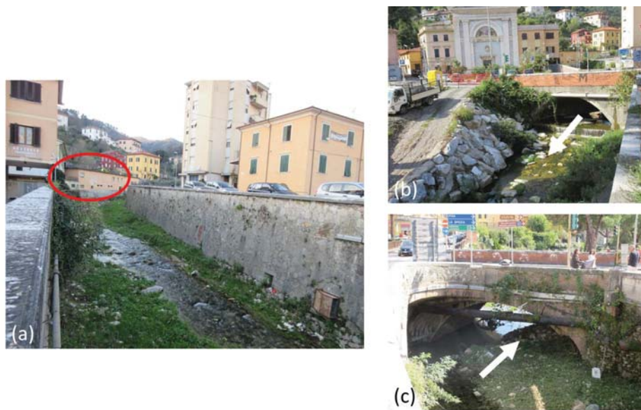
Figura 3.18: Il ponte della Lugnola visto da valle (b) e da monte (c) ed il tronco finale del Gragnana: sullo sfondo un edificio adiacente l'alveo (a).
