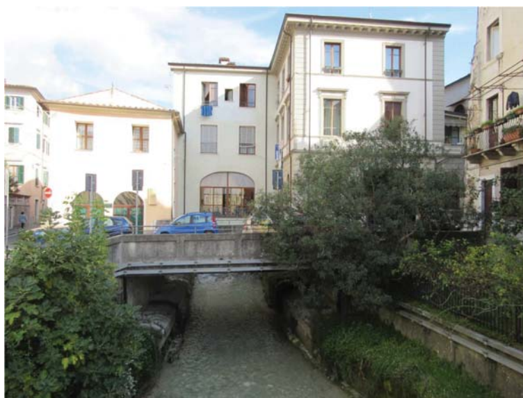
Figura 2.10: Il ponte Forti. Si noti in sinistra idrografica un giardino, di pertinenza dell'edificio adiacente l'alveo, che ostruisce il tratto di alveo a servizio della campata di sinistra del ponte delle Lacrime, che non risulta quindi idraulicamente attiva.
