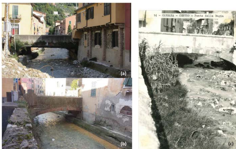
Figura 2.13: Il Ponte della Bugia nella configurazione attuale, visto da valle (a) e da monte (b) è messo a confronto con la sua configurazione negli anni '60 (c) (Foto di R. Lazzarini, gentile concessione di M. Daddi)
