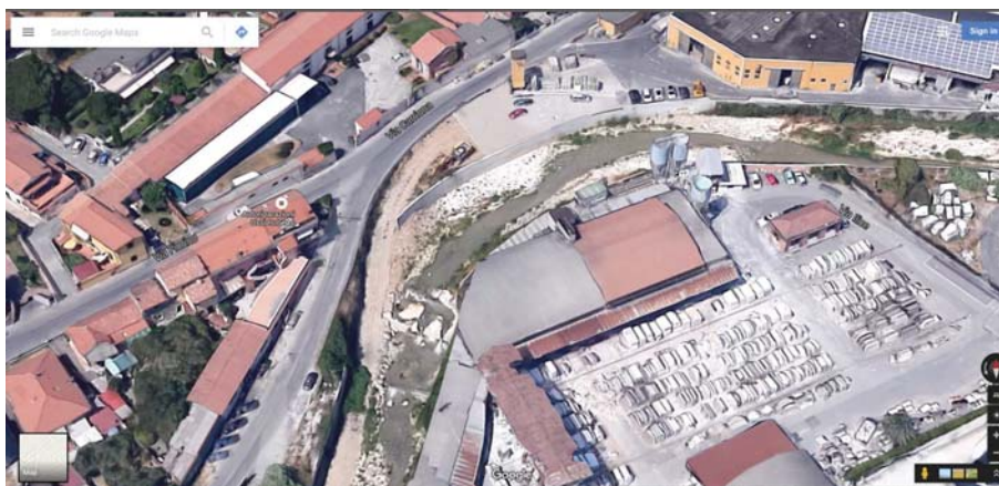
Figura 1.21: Difesa spondale in curva, costituita da muro in cemento armato non completato.
