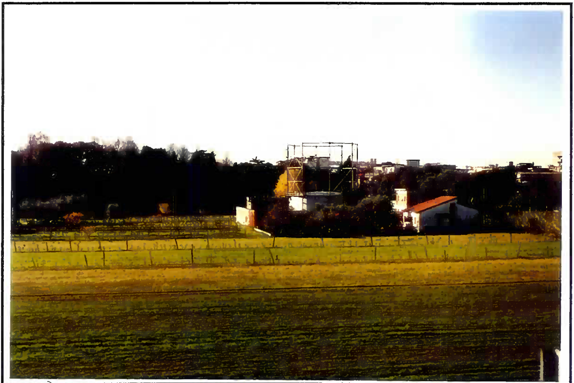
Foto n. 9 - Struttura metallica del gasometro Italgas.
