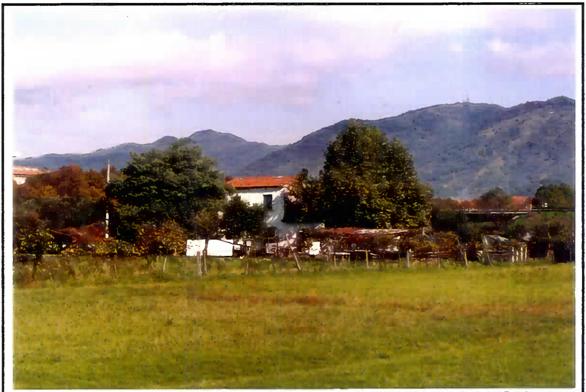
Foto n. 13 - Fabbricato idoneo per la realizzazione del "Centro Visite".
