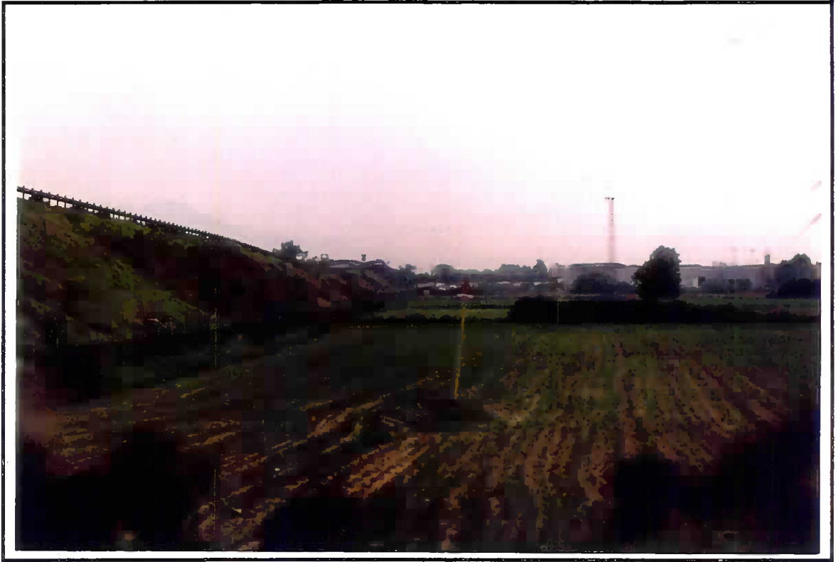
Foto n. 14 - Scarpata autostradale, tratto interessato dalla realizzazione della barriera vegetale su terrapieno.
