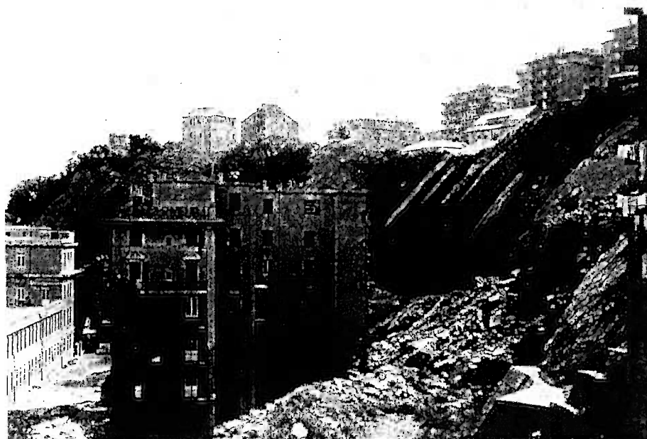
Frana di un vecchio fronte di cava a Genova su un edificio sottostante (19 morti). (Foto tratta da: Relazione introduttiva al convegno: Cave e assetto del territorio, di F.Bocchi, 1975).
