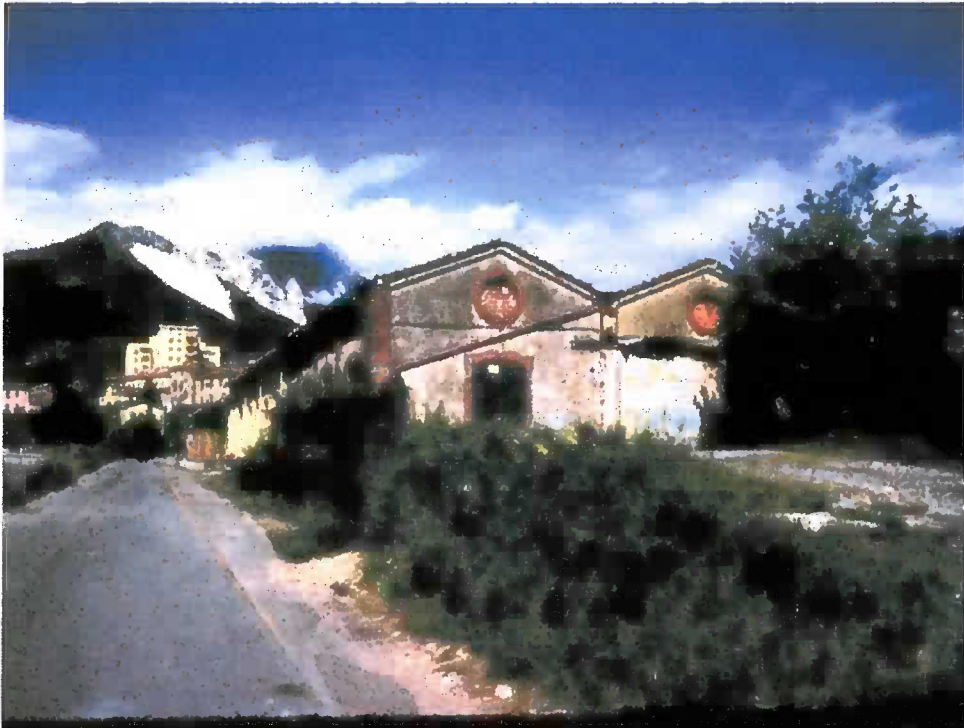
Nella foto una vecchia stazione della ferrovia marmifera
