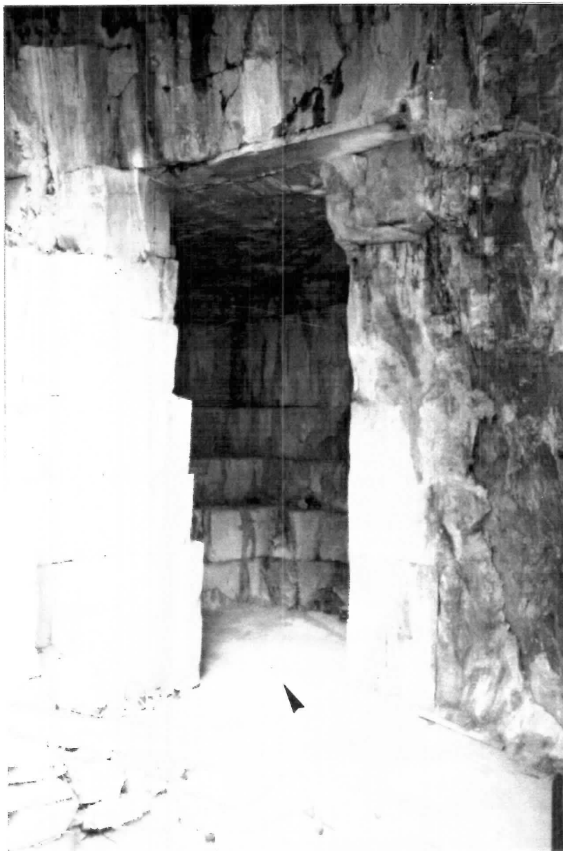
FIGURA 9 TIPOLOGIA DI CAVA IN GALLERIA
