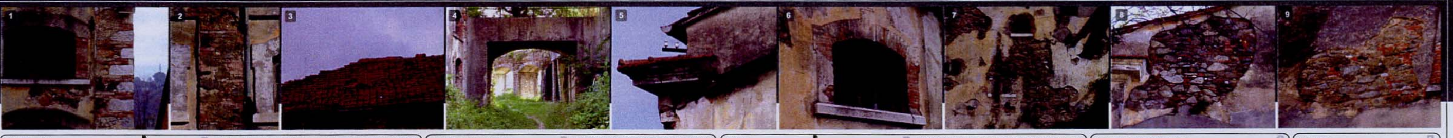
1 La Parate angolari. Nella realizzazione della muratura della segheria e' stato posto particolare riguardo a stato posto nell'esecuzione degli angoli degli edifici. I punti più sollecitati della struttura, dove sottoforma di parate angolare viene aumentata la sezione resistente della muratura. Le parate angolari sono realizzate in blocchi di marmo squadati e ricorsi di mattoni, il che conferisce loro una maggiore resistenza alle sollecitazioni rispetto al resto della muratura non squadata e di sezione minore. Così il codice decorativo necessario, definito anche da un fregio, dalle cornici delle aperture. 2 d'alla simmetria della facciata e da altre modanature rivela, in quest'esempio di architettura utilitaristica, una corrispondenza con le regole strutturali e le necessità funzionali. 3 Copertura del padiglione minore. Il padiglione minore solo apparentemente è identico al primo. In realtà è diverso nella storia (venne costruito nel 1903, trent'anni dopo il primo ma fu utilizzato solo fino al 1939, secondo la testimonianza di M. Remolini, che ha lavorato nella segheria di Vignola gli ultimi anni in cui era in funzione). 4 Proprio la copertura del padiglione minore tradisce il fatto i due edifici non furono concepiti dallo stesso progettista. Infatti sebbene la morfologia della facciata sia la stessa per entrambi, gli appoggi delle capriate non insistono in corrispondenza delle parate ma sono spostate in funzione dello spazio interno. 5 Le cornici. Tutte le aperture sono messe in risalto da cornici aggettanti, eseguite in mattoni, fatta eccezione dei davanzali delle finestre, costituiti da mensole in marmo. Ancora marmo è utilizzato come elemento di finitura (sovrano accostato dall'intonaco) nelle modanature del fregio. Le modanature del fregio sono realizzate in mattoni pieni tagliati a 45 l'intero manufatto è rifinito all'interno e all'esterno con un intonaco formato da 6 tre diversi strati (come ben si distingue dalle parti distaccate, il Rinzaffo (strato di ancoraggio o di aderenza), l'arriccio, la finitura (o velo) e la tinteggiatura. 7 Aperture per l'albero di trasmissione. Attraverso queste aperture praticate nella muratura passava l'albero di trasmissione principale e altri meccanismi necessari appunto a trasmettere il movimento ad un telaio posto all'esterno del padiglione maggiore. A protezione di questo telaio venne annesso al complesso un piccolo corpo di fabbrica che è visibile in una foto storica della segheria. Successivamente fu demolito ed oggi ne rimane traccia solo nell'attacco della sua copertura alla parete della segheria. 8 La muratura. Grosse lacune di tutti gli strati formanti l'intonaco (finitura, arriccio, rinzaffo), lasciano a vista la muratura. Questa è composta da pietre miste non squadrate, ciottoli di fiume e il terreno di Vignola è ex alveo dei torrenti Carloni e laterali legati con malta di calce probabilmente aerea.
