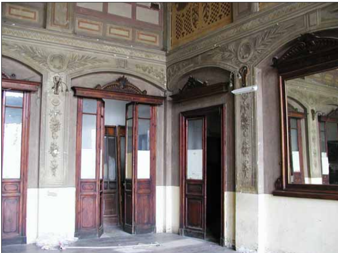
Figura I/17 – Particolare degli arredi in legno e delle decorazioni originali presenti nel Salone
