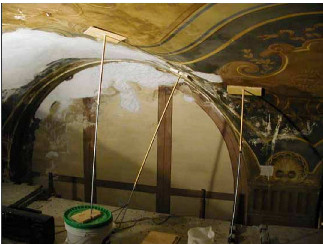
Figura III/33 – stuccature eseguite a malta grossa e a malta fine, sullo sfondo
