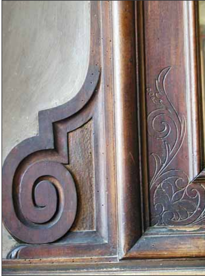
Figura III/35 – Specchiera infestata da insetti xilofagi, particolare
