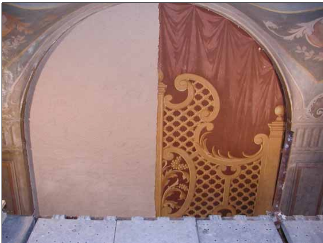
Figura III/26 – Pulitura di un matroneo eseguita a zone
