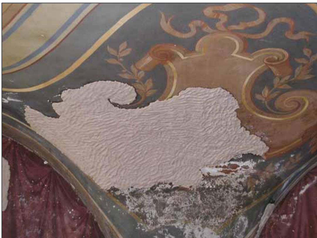
Figura III/25 – Pulitura eseguita mediante impacco di pasta di cellulosa e carbonato d'ammonio
