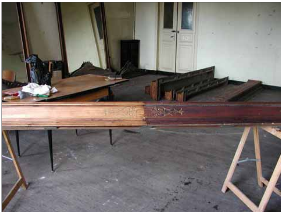
Figura III/36 – Pulitura dei manufatti in legno
