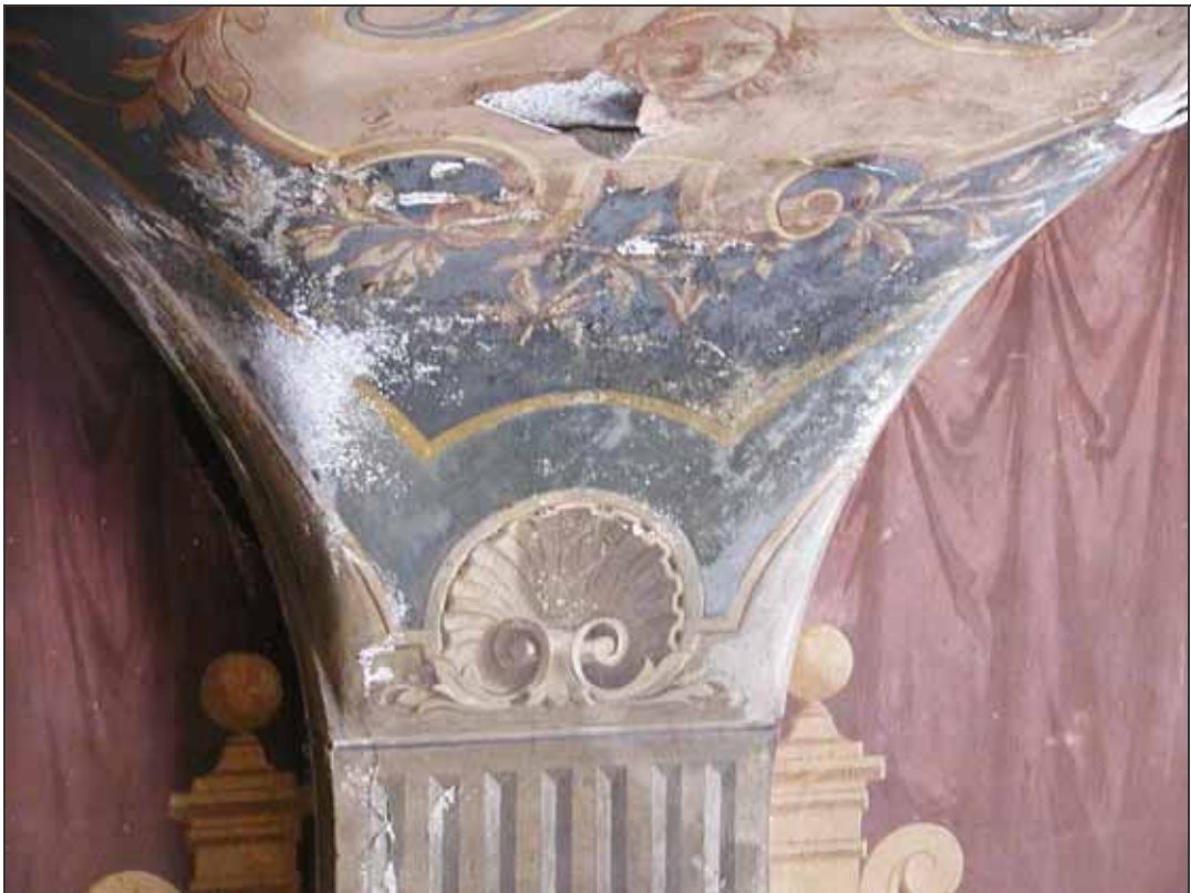
Figura III/14 – Patina biancastra e opacizzazione della superficie pittorica causata dalla fuoriuscita di sali idrosolubili
