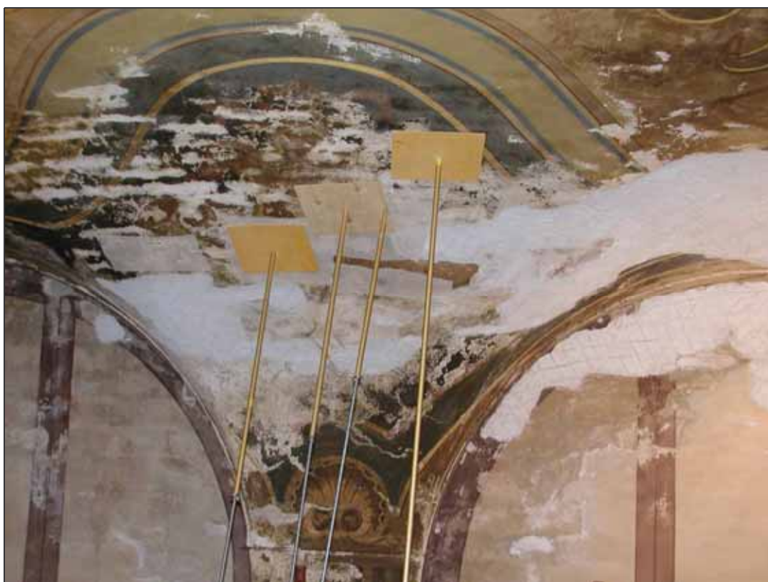
Figura III/32 – Applicazione dei puntelli di sostegno dopo l'operazione di consolidamento
