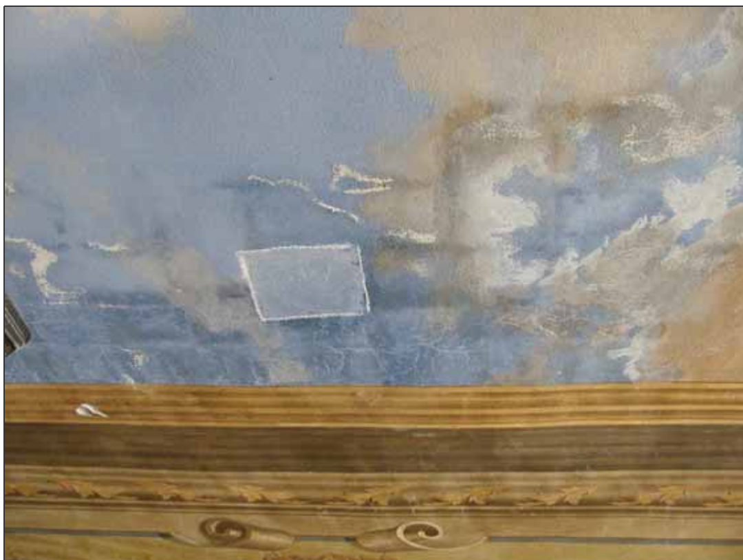
Figura III/24 – Tassello di pulitura sul soffitto
