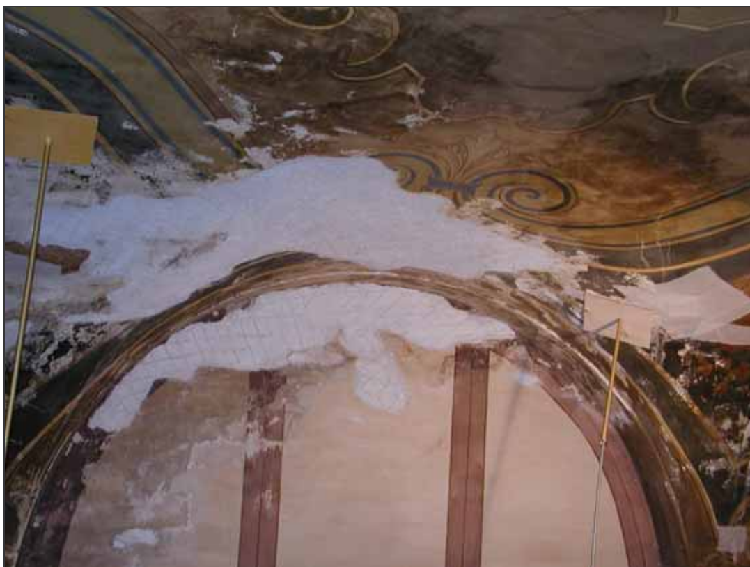
Figura III/34 – Stuccature dell'arriccio eseguite a malta grossa
