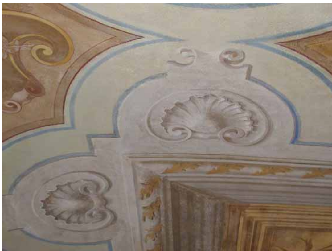
Figura III/41 – Soffitto del “Salone Germinal” a restauri conclusi
