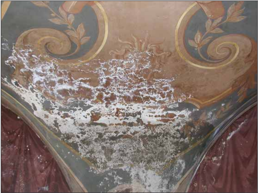
Figura III/13 – Fuoriuscita di sali idrosolubili sotto forma di patina biancastra
