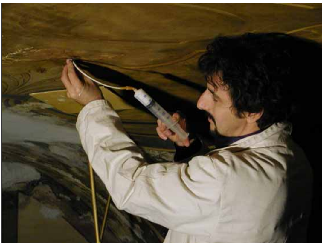
Figura III/31 – Consolidamento mediante iniezioni
