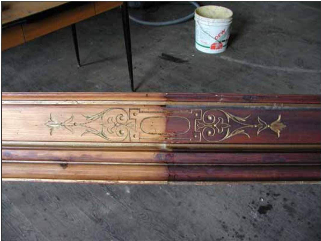
Figura III/37 – Pulitura di un sopratenda, prima e dopo
