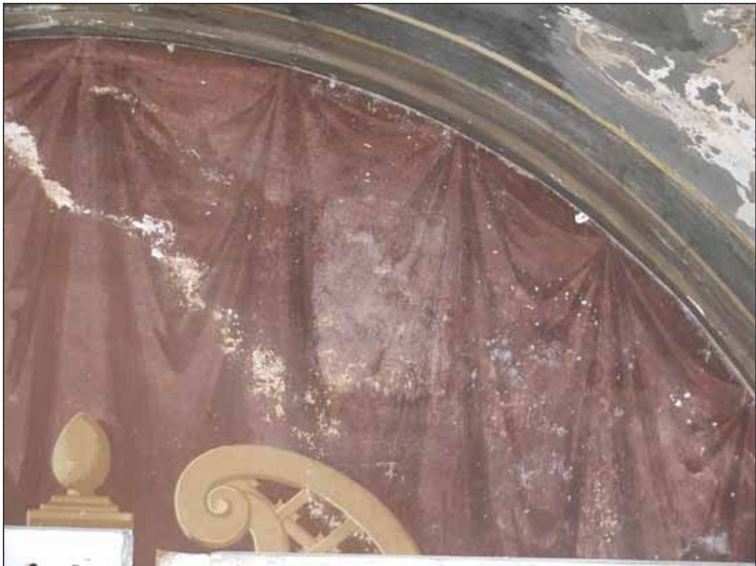
Figura III/28 – Velo biancastro causato dalla reazione chimica avvenuta tra il carbonato d'ammonio presente nell'impacco di pulitura e un fissativo applicato in origine
