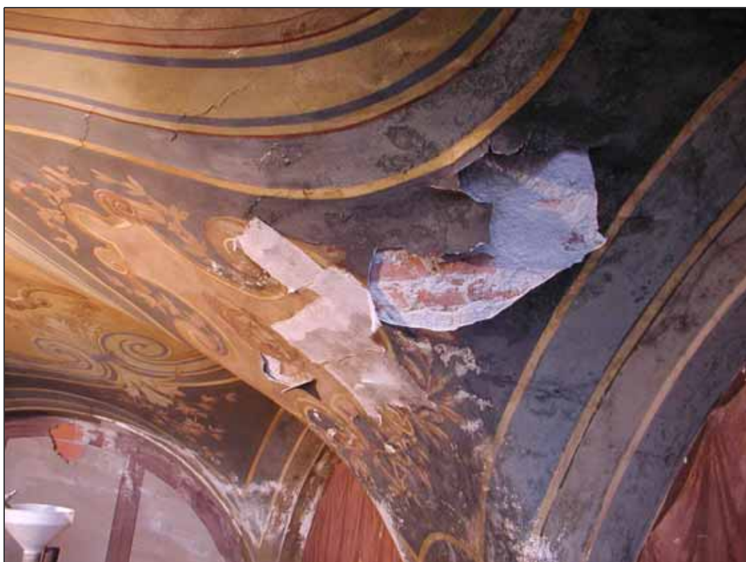
Figura III/22 – Applicazione dei bendaggi per mezzo di velatino di garza bagnato con resina acrilica
