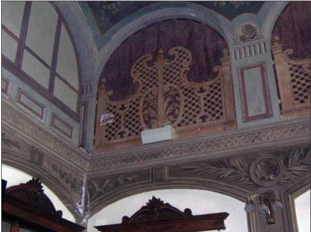
Figura IV/11 – Foro nel matroneo causato dalla messa in opera di una scatola per fili elettrici
