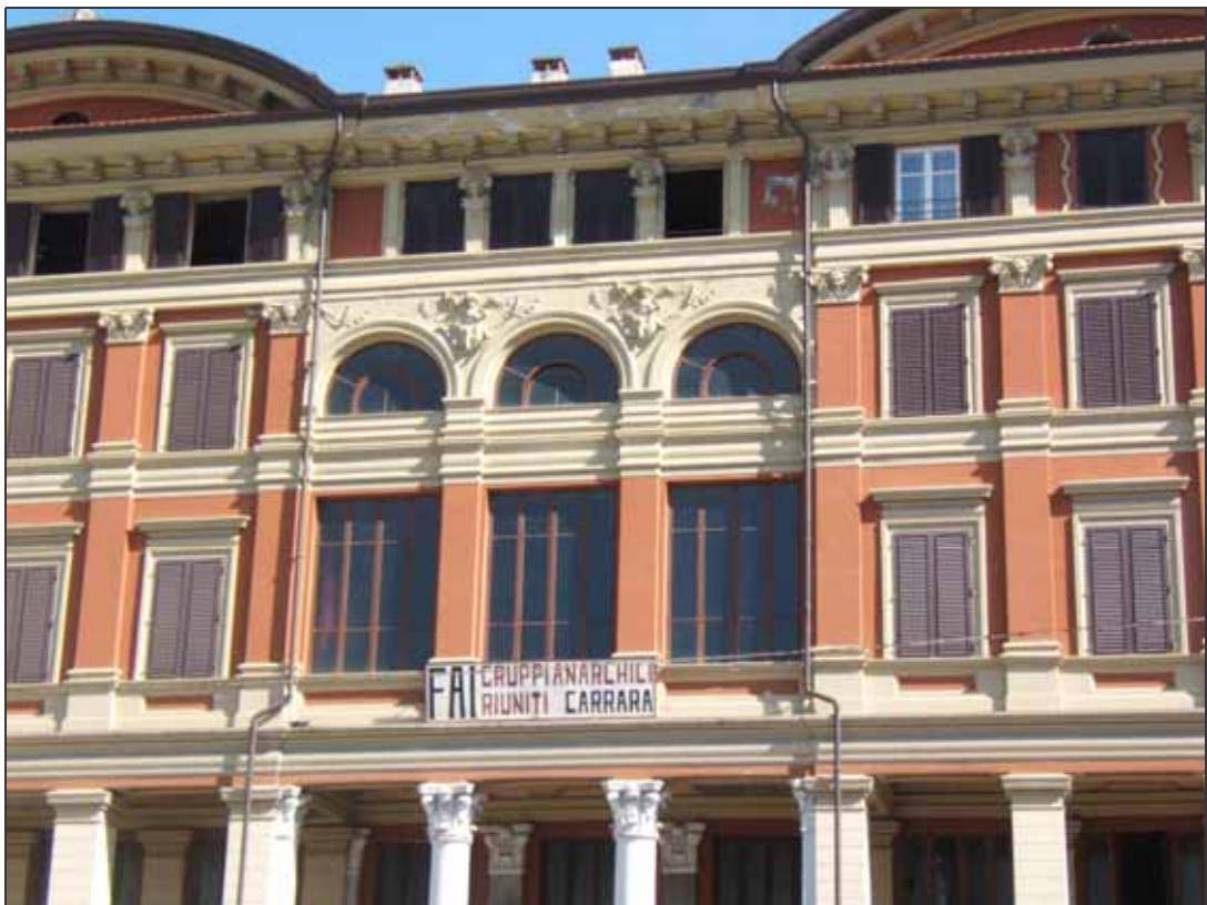
Figura IV/4 – Veduta esterna del “Salone Germinal” attualmente sede della FAI, settembre 2006
