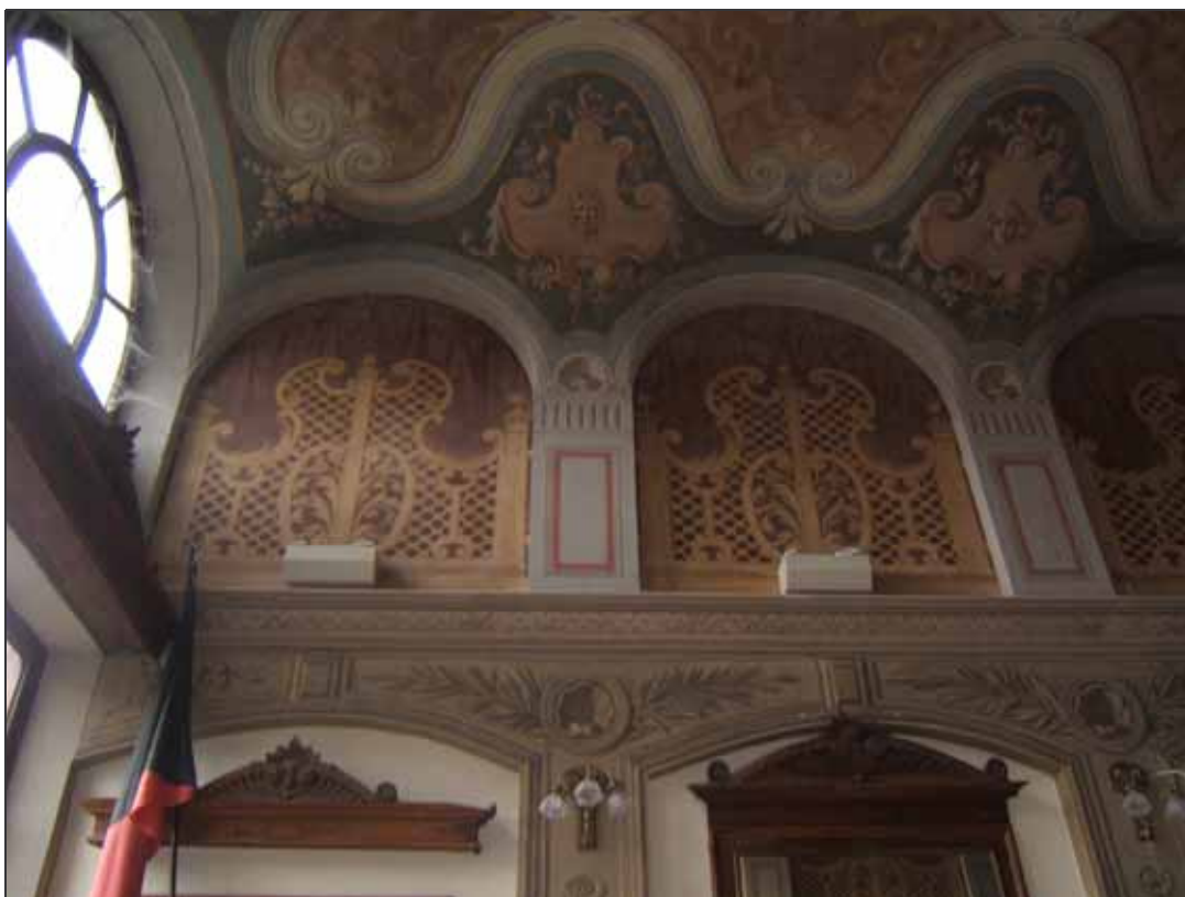
Figura III/42 – Un’area del “Salone Germinal” dopo il restauro
