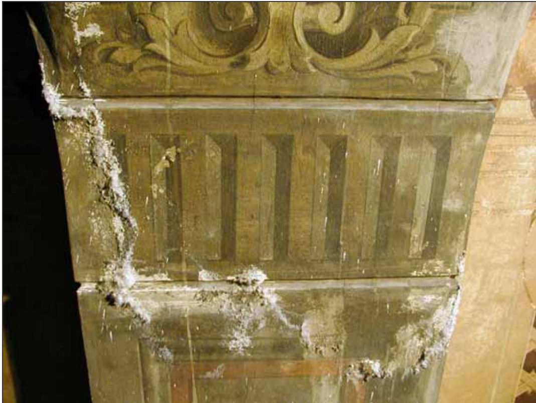
Figura III/11 – fuoriuscita di sali idrosolubili sotto forma di filamenti e conseguente caduta del film pittorico
