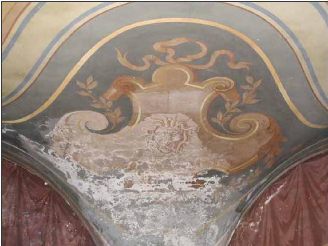
Figura III/27 – Comparsa di un velo biancastro e alterazione della superficie pittorica
