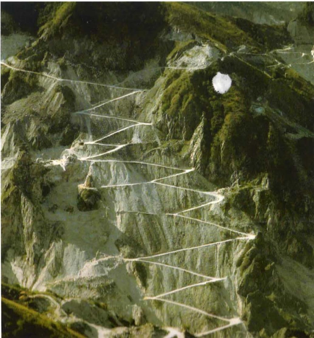
Foto 10. Strada di arroccamento: solitamente molti tratti vengono percorsi invertendo la direzione di marcia del mezzo
