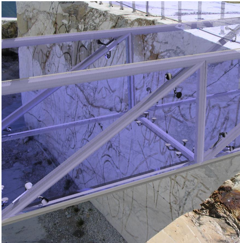
Figura 23: dettaglio passerella sospesa
