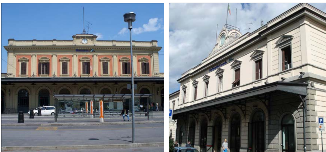
Figure 3.1 - 3.2 - Le due stazioni di inizio e fine della linea: a sinistra la stazione di Parma (fonte: http://www.panoramio.com ), a destra la stazione di La Spezia Centrale (fonte: http://www.panoramio.com ).
