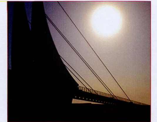
PARTICOLARE PROSPETTIVA ALI E PASSERELLA - LATO MALE COLOMBO
