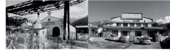
edificio adibito alla segazione dei blocchi _segheria "Walton" superiore
