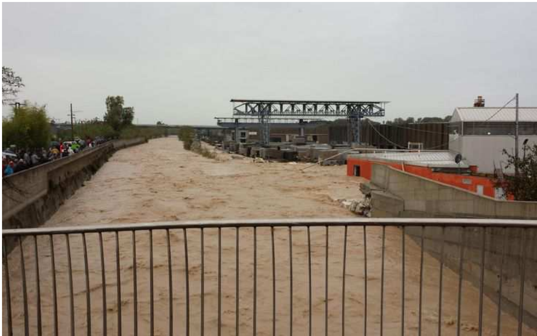
AVENZA: CEDIMENTO DELL'”ARGINE” DEL TORRENTE CARRIONE 5.11.2014
