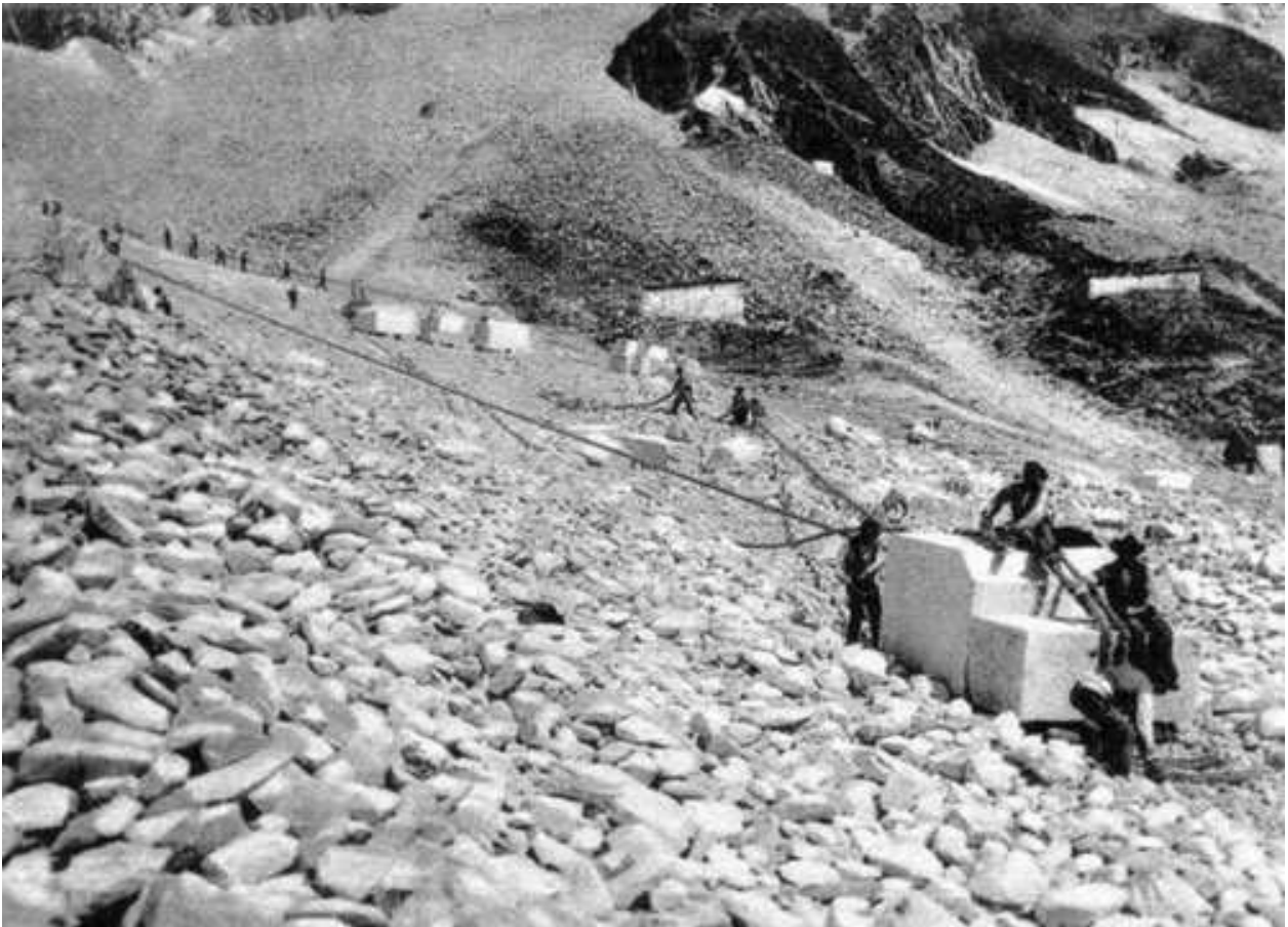
LA LIZZATURA, SISTEMA PER FAR SCENDERE I BLOCCHI AL PIANO : NELLA FOTO SI POSSONO CONTARE UNA VENTINA DI OPERAI
