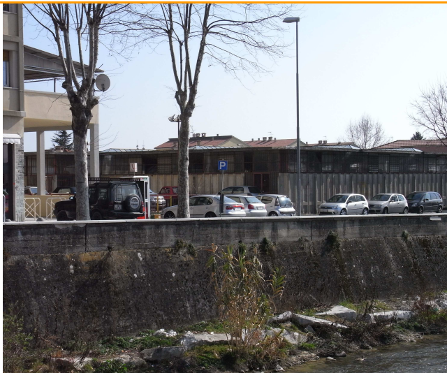
Prospetto occidentale visto dal ponte
