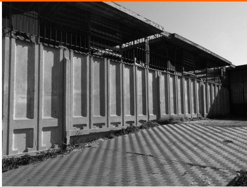
Rampa d'ingresso su via Argine Sinistro
