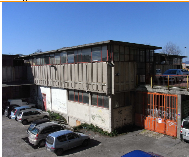
Vista dal loggiato del palazzo adiacente
