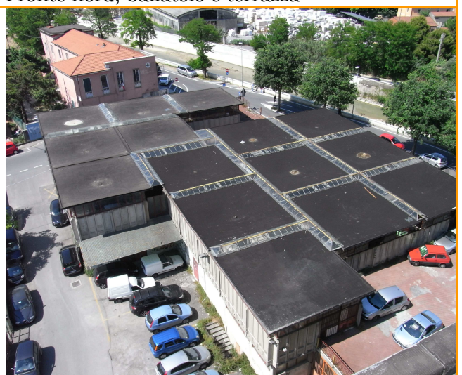
La copertura ad impluvi ed i lucernari
