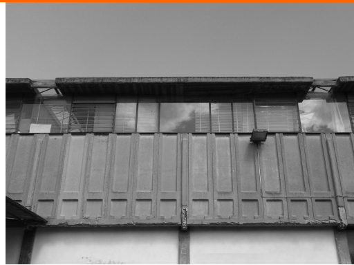
Dettaglio dei pannelli prefabbricati in c.a.
