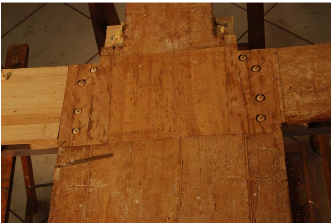
Figura 77 – Duomo di Carrara, Croce lignea sec XIV, restauro del 2006-2008 del laboratorio Lo Studiolo di Lucca, fase di risanamento del supporto, alloggiamento del braccio destro e sinistro nell'asse verticale. Foto del laboratorio di restauro Lo Studiolo di Lucca.
