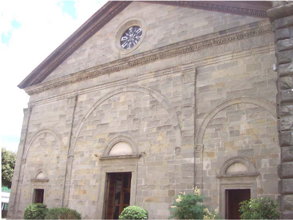
Figura 57 - Duomo dei SS. Apostoli Pietro e Paolo di Castelnuovo in Garfagnana (Lucca), facciata. Foto dell'autore, Luglio 2009.
