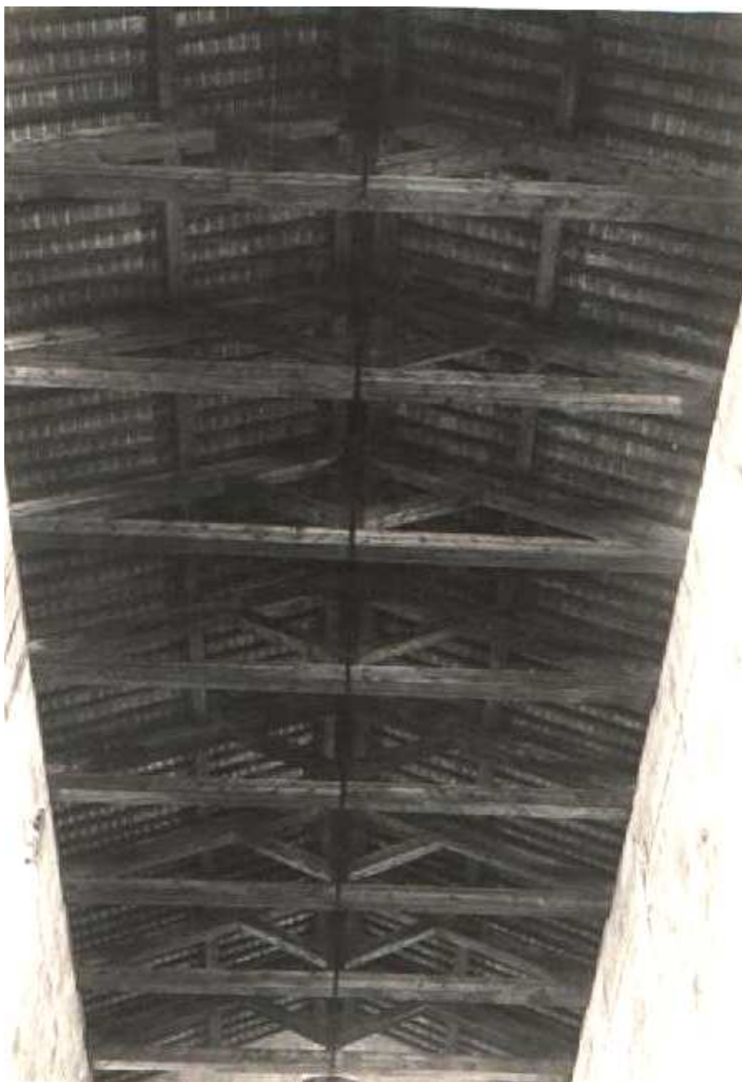
Figura 15 – Duomo di Carrara, copertura in capriate di cemento armato rivestite in legno al 1948. Foto del 1948, Archivio fotografico della Soprintendenza per il patrimonio storico, artistico ed etnoantropologico e per i beni architettonici e del paesaggio per le province di Pisa e Livorno.
