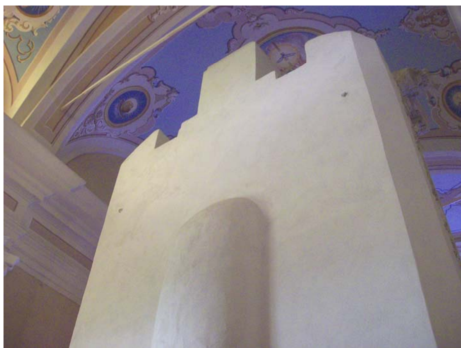
Figura 50 - Chiesa dei Santi Vito, Modesto e Crescenza a Gravago di Bardi (Parma), struttura di sostegno in cemento intonacato posta nel retro dell'Altare Maggiore, già Altare dell'Immacolata Concezione, proveniente dal Duomo di Carrara. Foto dell'autore, Luglio 2009.
