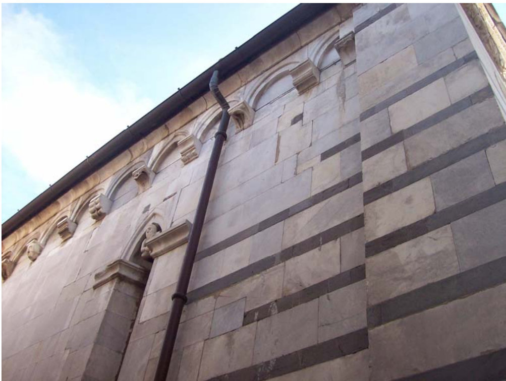
Figura 12- Duomo di Carrara, parete dell'angolo nord-ovest con la zona dove esisteva il vano d'accesso alla cantoria marmorea. Foto dell'autore settembre 2009.
