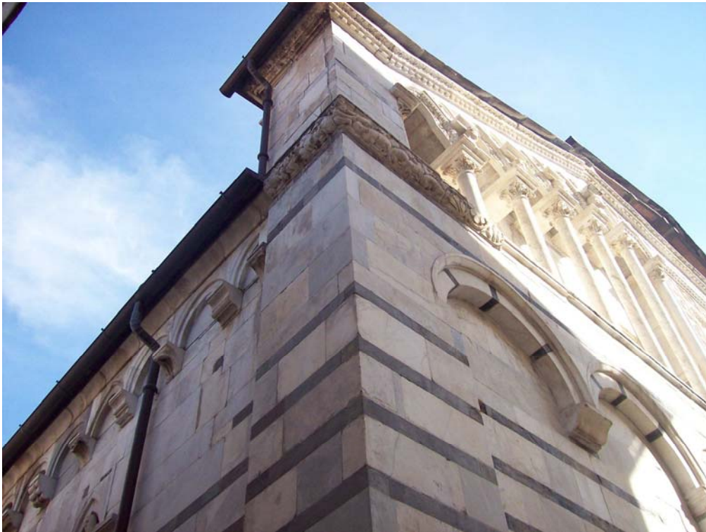
Figura 11- Duomo di Carrara, pilastro dell'angolo nord-ovest. Foto dell'autore settembre 2009.
