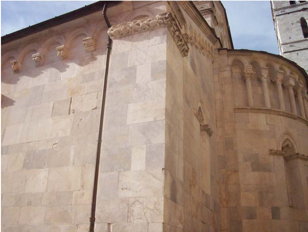
Figura 9 – Duomo di Carrara, pilastro dell'angolo sud-est. Foto dell'autore luglio 2009.
