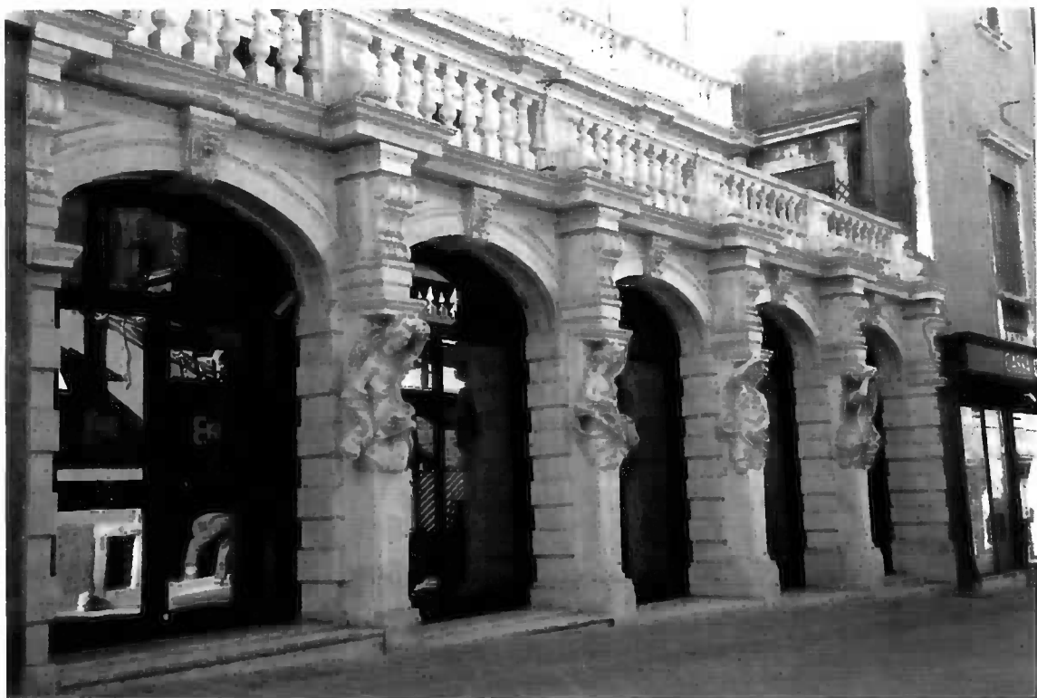
fig.22 Entrata del giardino del palazzo Pisani
