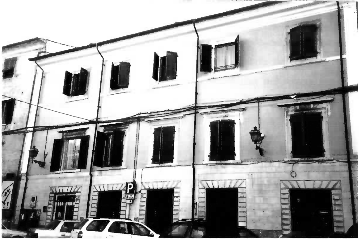
fig.7 Casa del comune
