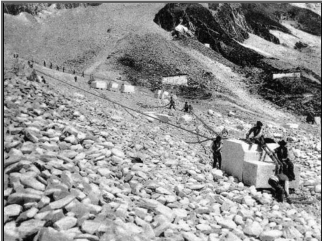
Trasporto a valle di un blocco di marmo mediante lizzatura – Fonte “Cartoline di Carrara”
