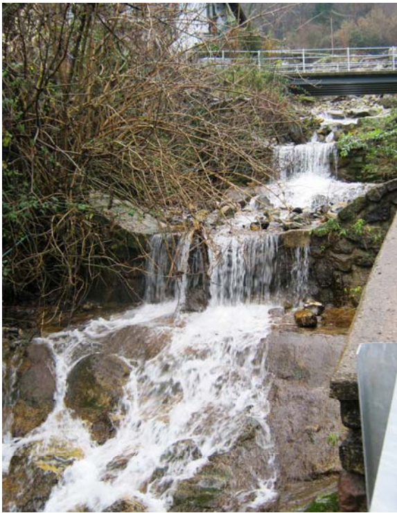
Fotografia 3.1.1.4 – Briglie di regimazione sul torrente Tufere
