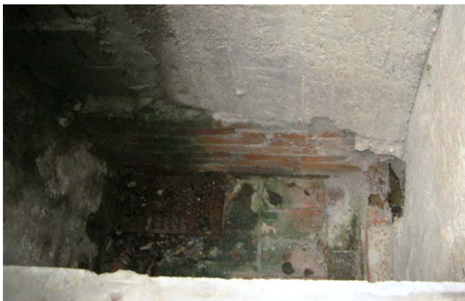
Fotografia 4.5.1 – Collegamento della centrale con il canale di scarico, oggi chiuso da una parete di mattoni
