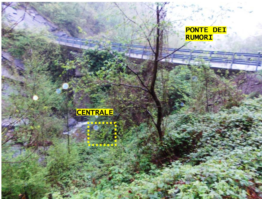
Fotografia 5.1.3 – Sezione di rilascio, vista dalla sterrata di accesso, con indicazione della posizione del fabbricato di centrale.
