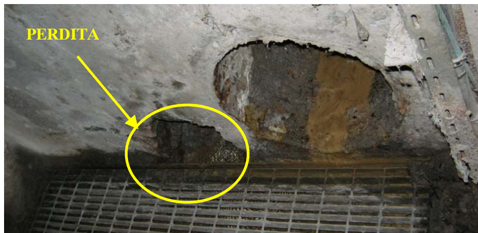
Fotografia 4.3.5.1 – Condotta forzata, sezione terminale: stato attuale
