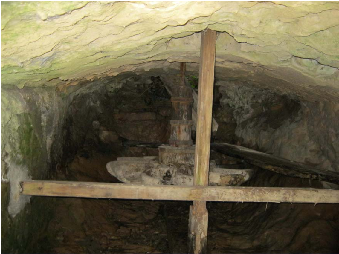
Figura 1.6.1.2 – Esempio di ruota orizzontale. Mulino di Arlia, Fivizzano (MS)
