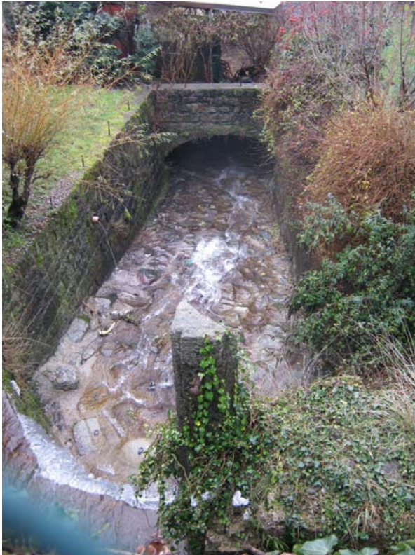
Fotografia 3.1.2.1 – Tratto d'alveo subito a valle della briglia.
