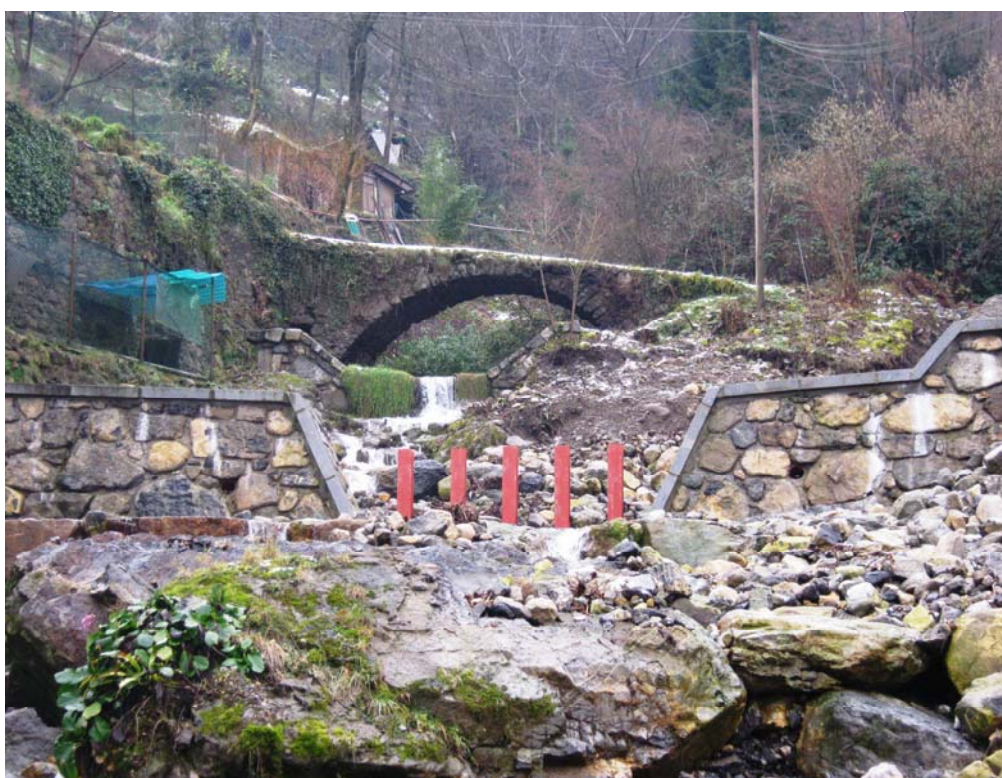
Fotografia 3.1.1.3 – Briglia frangicolata sul Torrente Tufere
