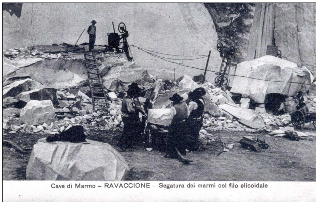
Figura 29:Cava lavorata con filo elicoidale (Comune di Carrara, Settore Marmo).
