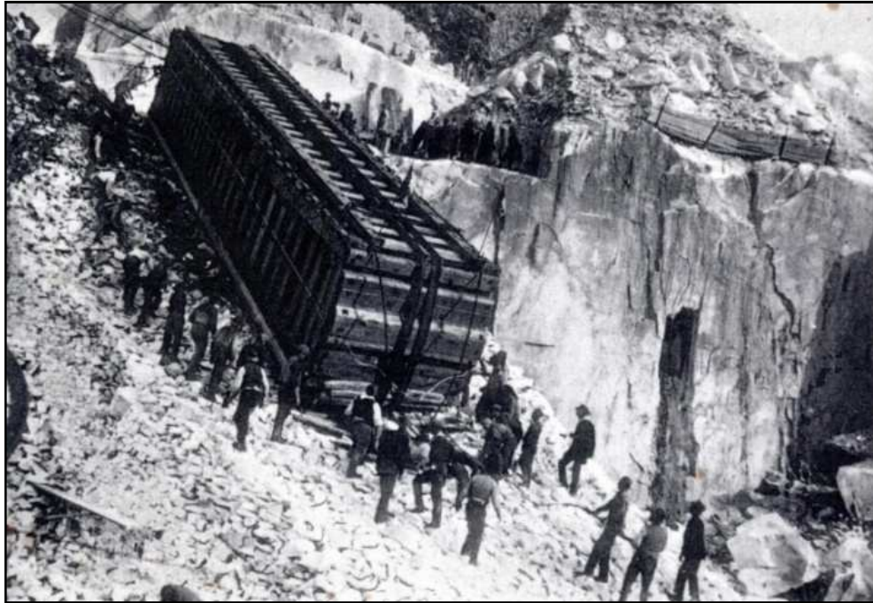
Figura 22: Lizzatura del monolite (Comune di Carrara, Settore Marmo).
