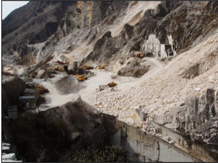
Figura 38: Località Battaglino, mezzi al lavoro per "il recupero del ravaneto".
