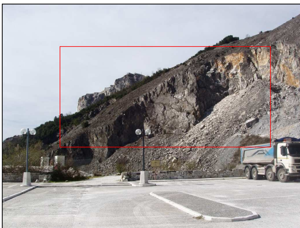
Figura 19: Particolare del ravaneto di Fossa dei Leoni 8/03/09, osserviamo pareti verticali al posto di una morfologia “naturale”, inoltre osserviamo modifiche nel profilo del rilievo del monte Betogli.
