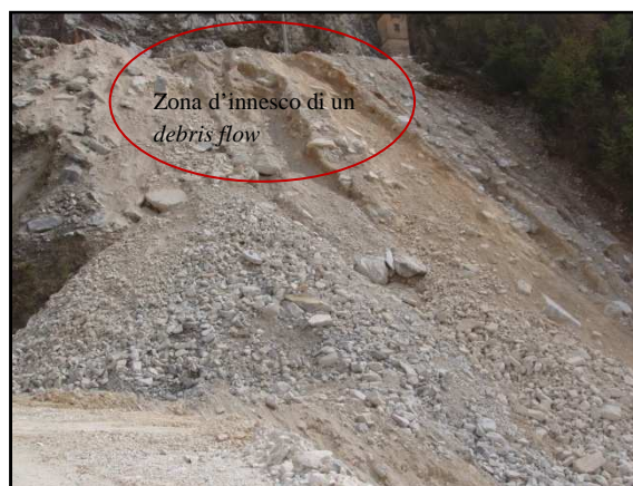
Figura 4: Debris flow in un ravaneto 20/02/09.
