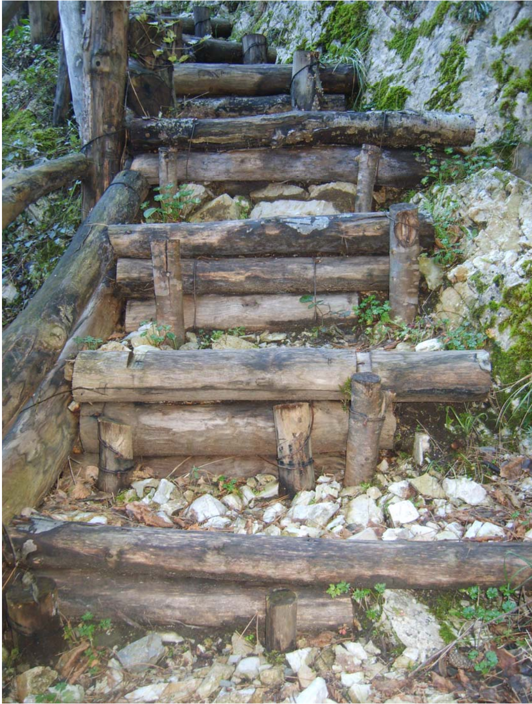
Foto 7.5: esempio di scalini in legno per i tratti più ripidi
