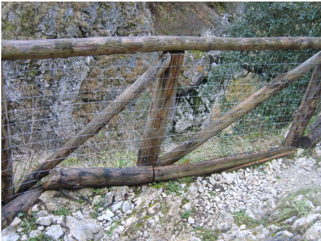
Foto 7.3: esempio di staccionata in legno con rete metallica protettiva.
