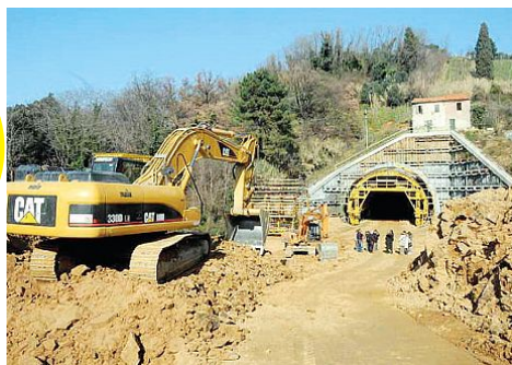
I lavori alla strada dei Marmi
