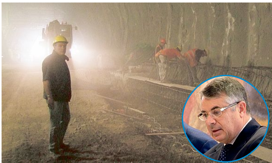
LAVORI Un operaio alla Strada dei Marmi, nel tondo il prefetto Giuseppe Merendino
